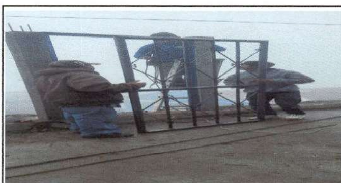
Foto 5: SUSTITUCION DE PORTON DE METAL
