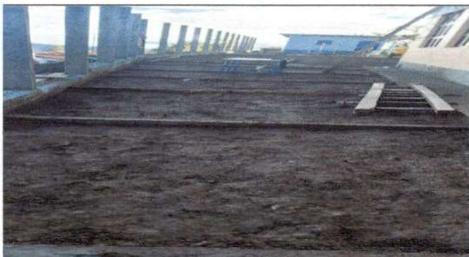
Foto 3: REPARACION DE MUROS PERIMETRALES
