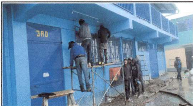
Foto1: SUSTITUCION DE BALCONES
